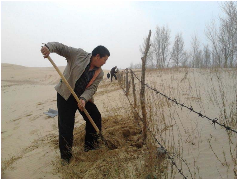
1：4月、管理チームが牧柵の修理を行っている様子です。 冬の間の強風で柵が砂に埋まってしまっています。
